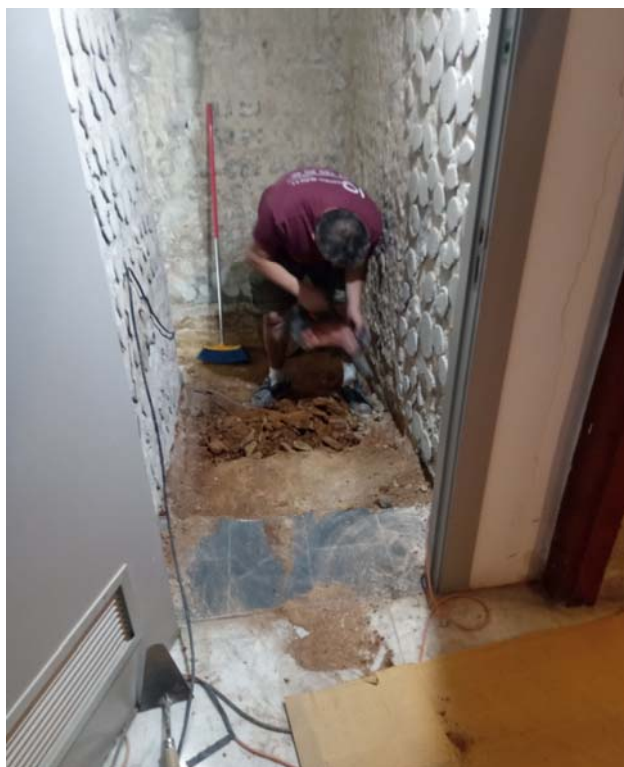
Foto 2. Excavació del fossat d'ascensor. Vista des del SE.
