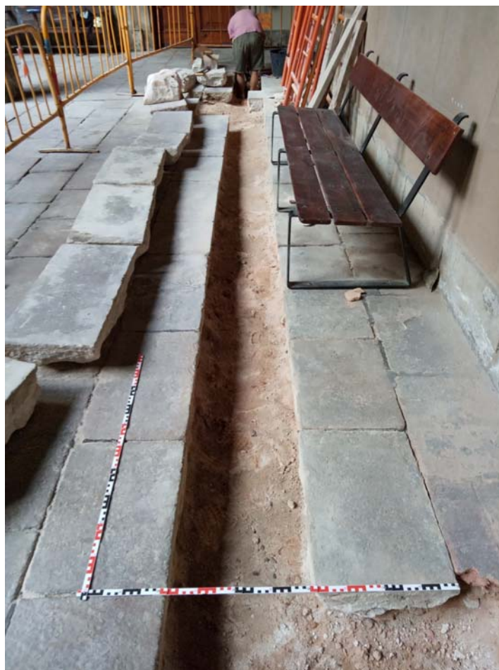
Foto 6. Vista inicial de la Rasa 1, un cop tretes les lloses del paviment, des del NE.
