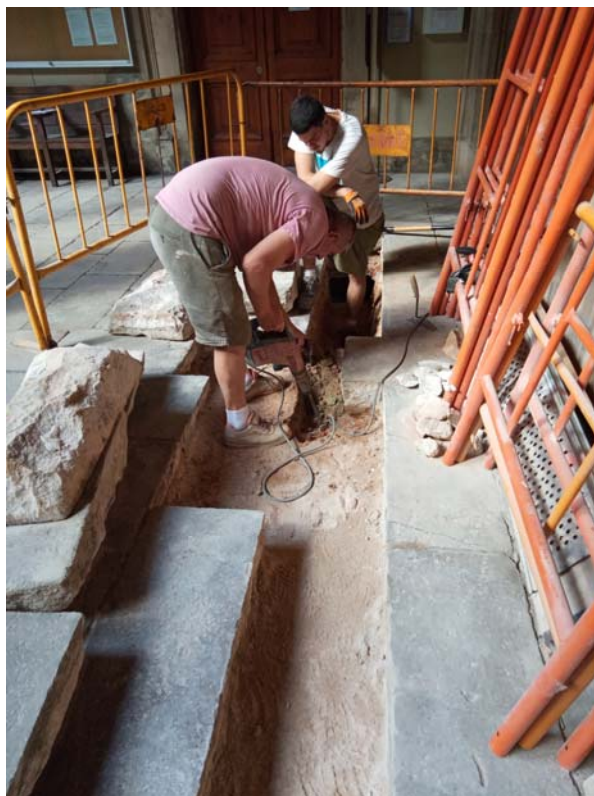
Foto 7. Excavació de la rasa. Vista des del NE.
