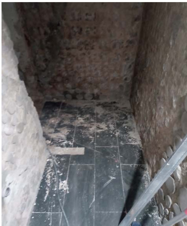
Foto 1. Vista inicial de l'espai on estava prevista l'excavació del fossat d'ascensor, des del NO.
