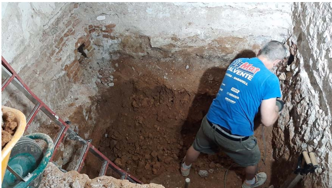
Foto 5. Excavació fossat ascensor. Feines de rebaix de la UE 6.
