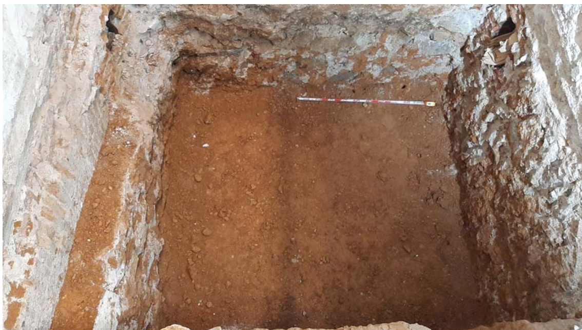
Foto 10. Foto final excavació fossat ascensor. Rebaix final de 1,52 m.
